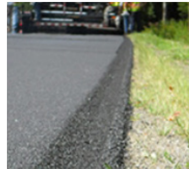
Calzada con borde en bisel
